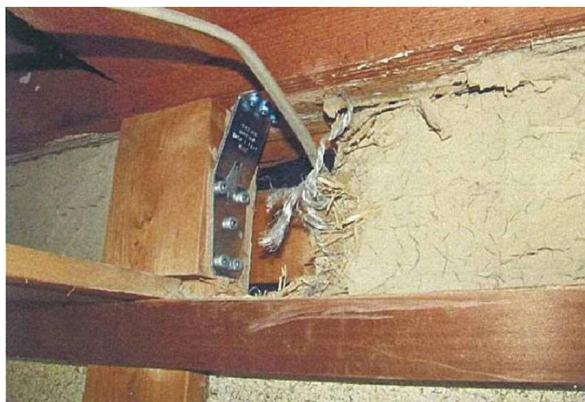
※仕口金物は、規定のビスを規定の本数施工されているか確認できるよう撮影してください。
