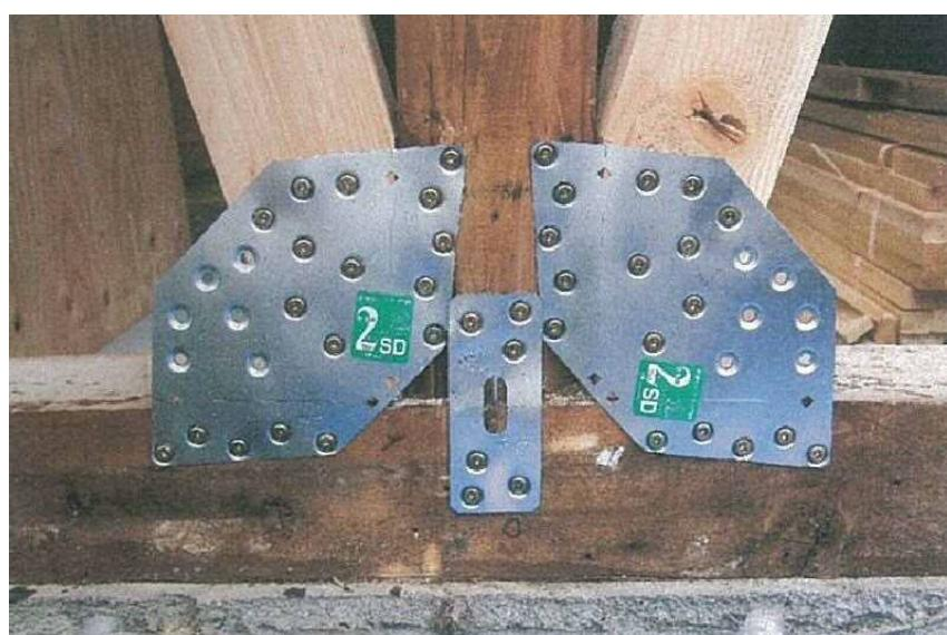
※筋交い金物も、規定のビスを規定の本数施工されているか確認できるよう撮影してください。
