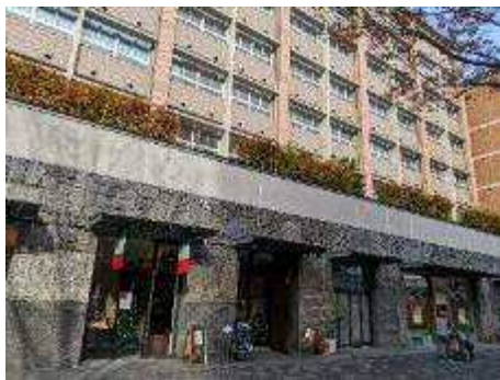
大通りから見た商業施設 (上写真)
