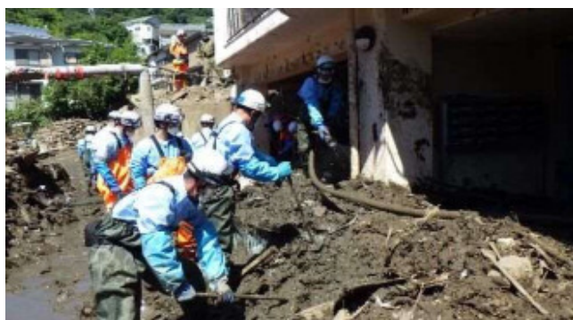
建物内に入った土砂を取り除く隊員
