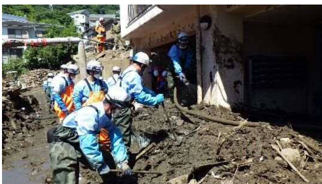
建物内に入った土砂を取り除く隊員
