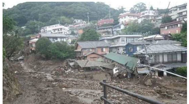
伊豆山地区の土砂災害状況
