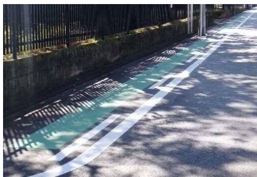
(例)通学路カラー舗装
