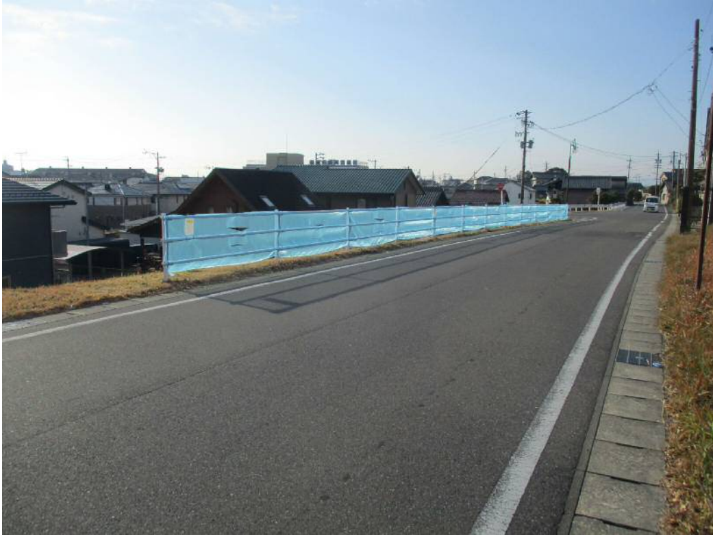
図 15 設置場所①（小信中島字宮前地内）の防虫ネット設置状況
