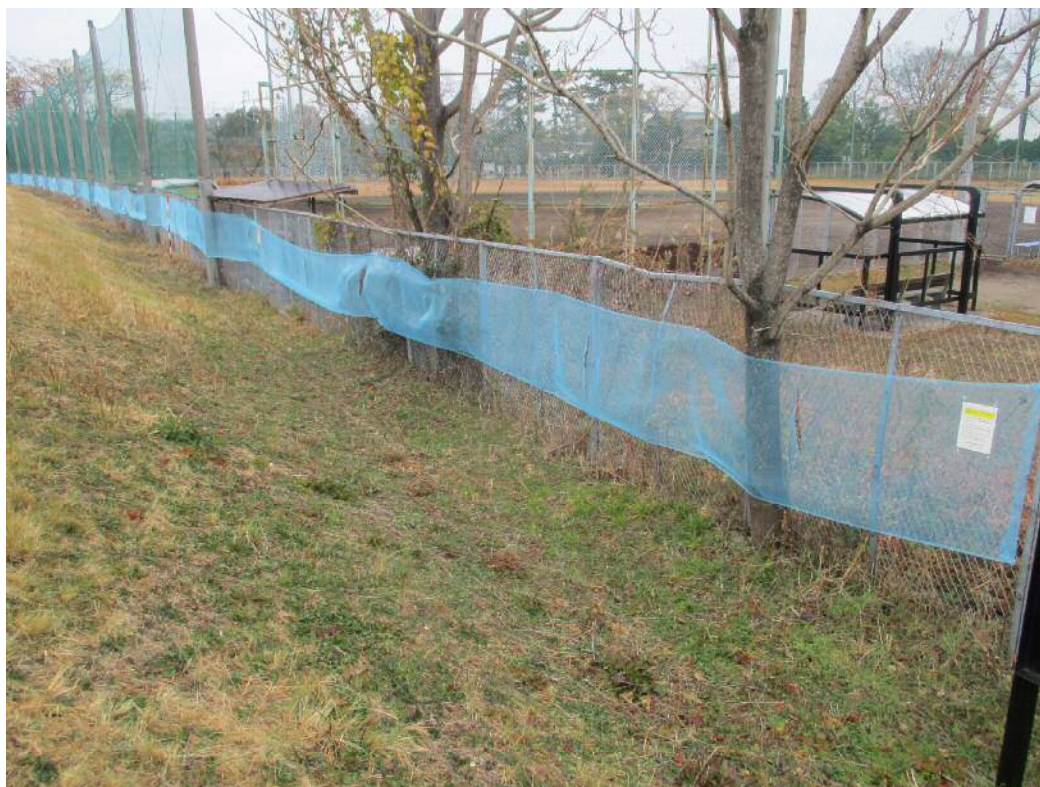
図 17 設置場所⑤（東加賀野井グラウンド）の防虫ネット設置状況
