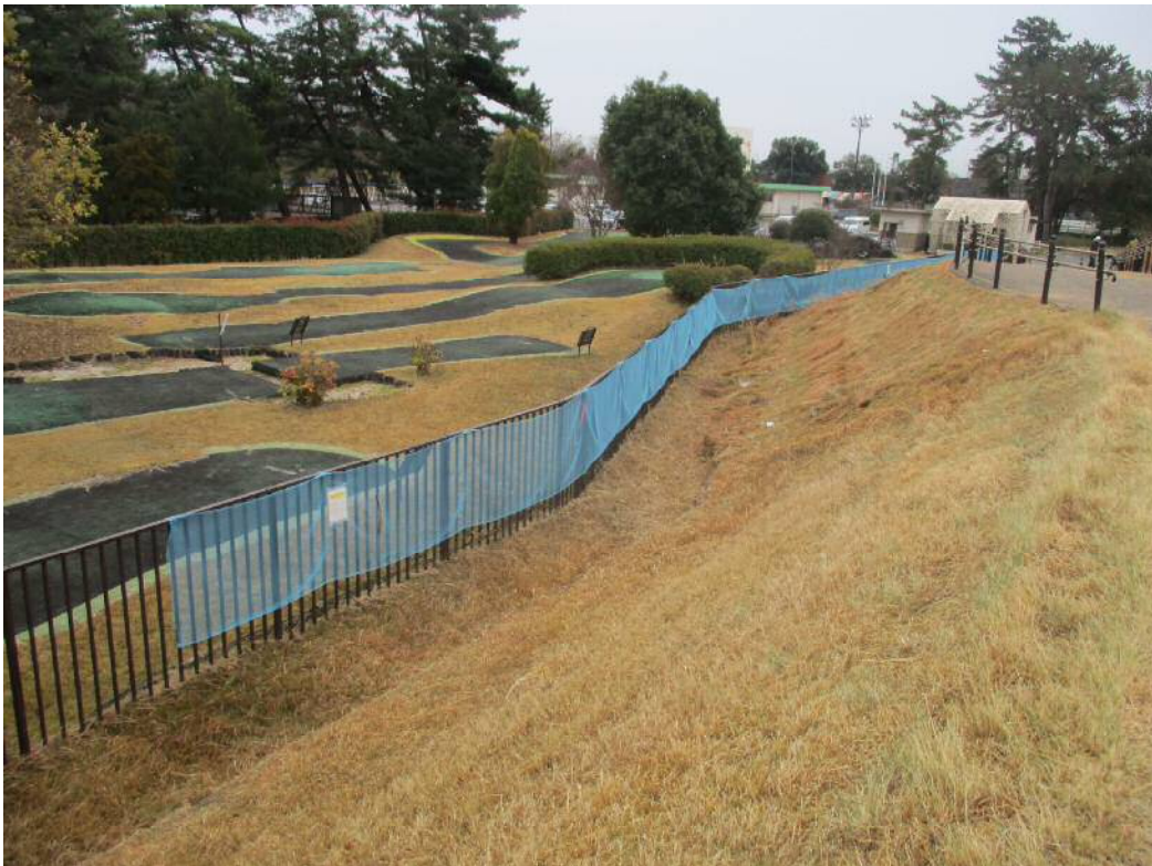
図 16 設置場所③（尾西グリーンプラザ）の防虫ネット設置状況
