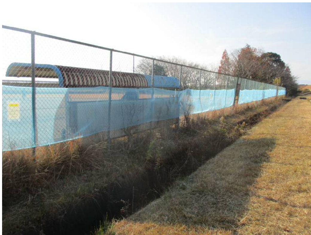
図 18 設置場所⑥（祐久グラウンド）の防虫ネット設置状況
