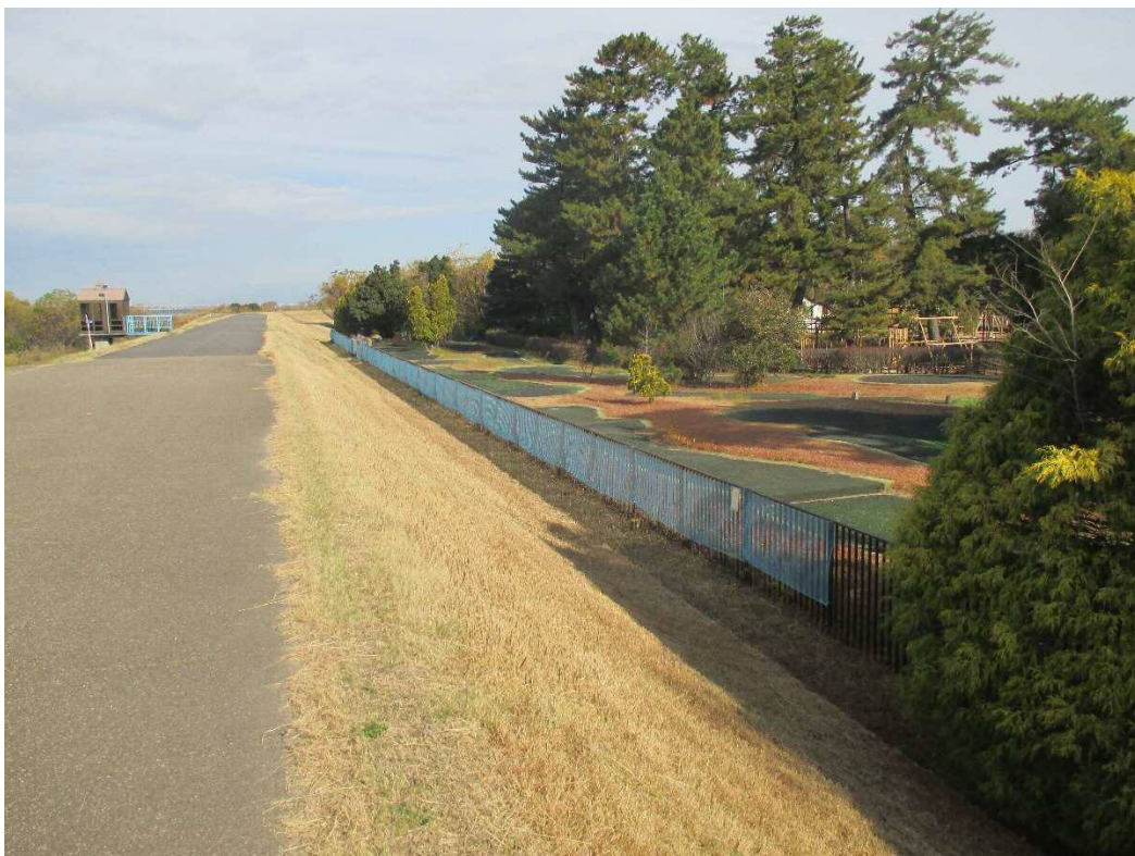
図 16 設置場所②（尾西グリーンプラザ）の防虫ネット設置状況
