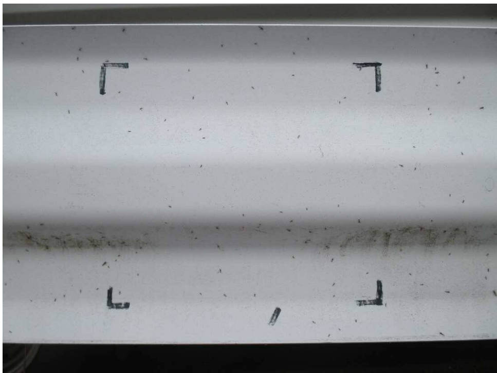
図 5 ガードレールに設けた観察枠
