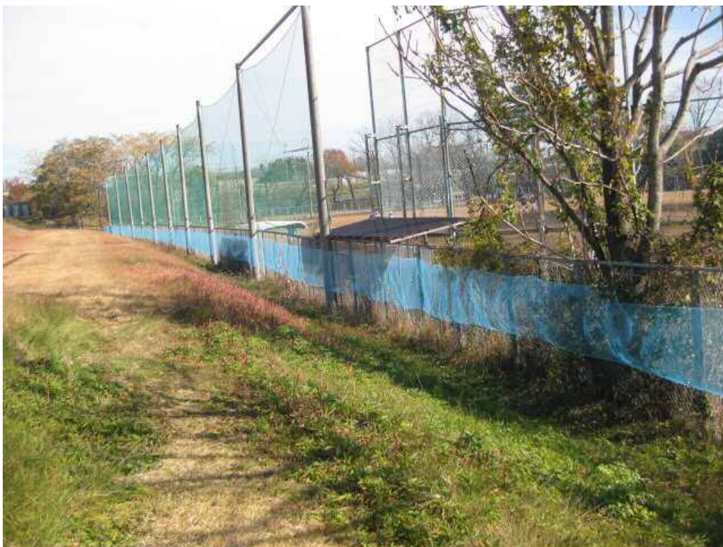
図 17 設置場所④（東加賀野井グラウンド）の防虫ネット設置状況
