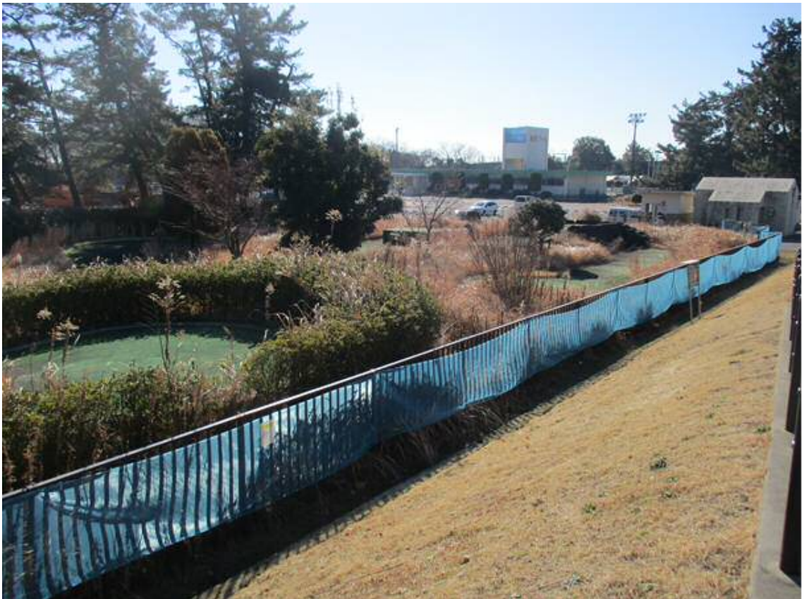
図 17 ③尾西グリーンプラザの防虫ネット設置状況
