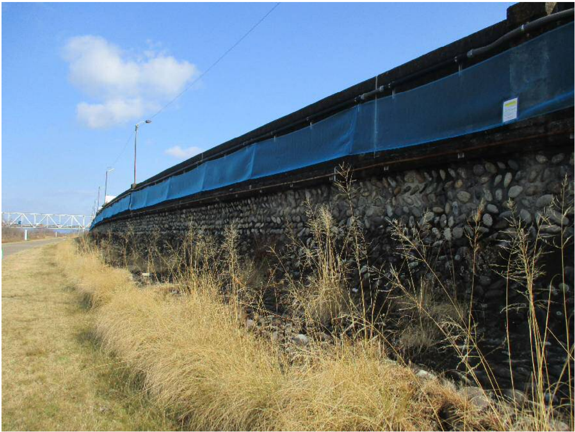
図 16 ①濃尾大橋下流側堤防の防虫ネット設置状況
