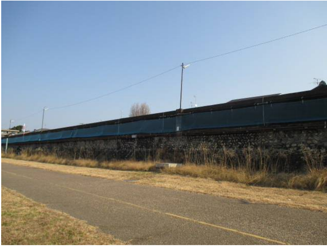
図 18 設置場所①（濃尾大橋下流側堤防）の防虫ネット設置状況
