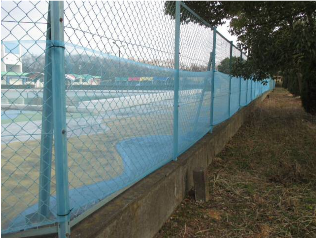
図 20 設置場所④（尾西プール）の防虫ネット設置状況
