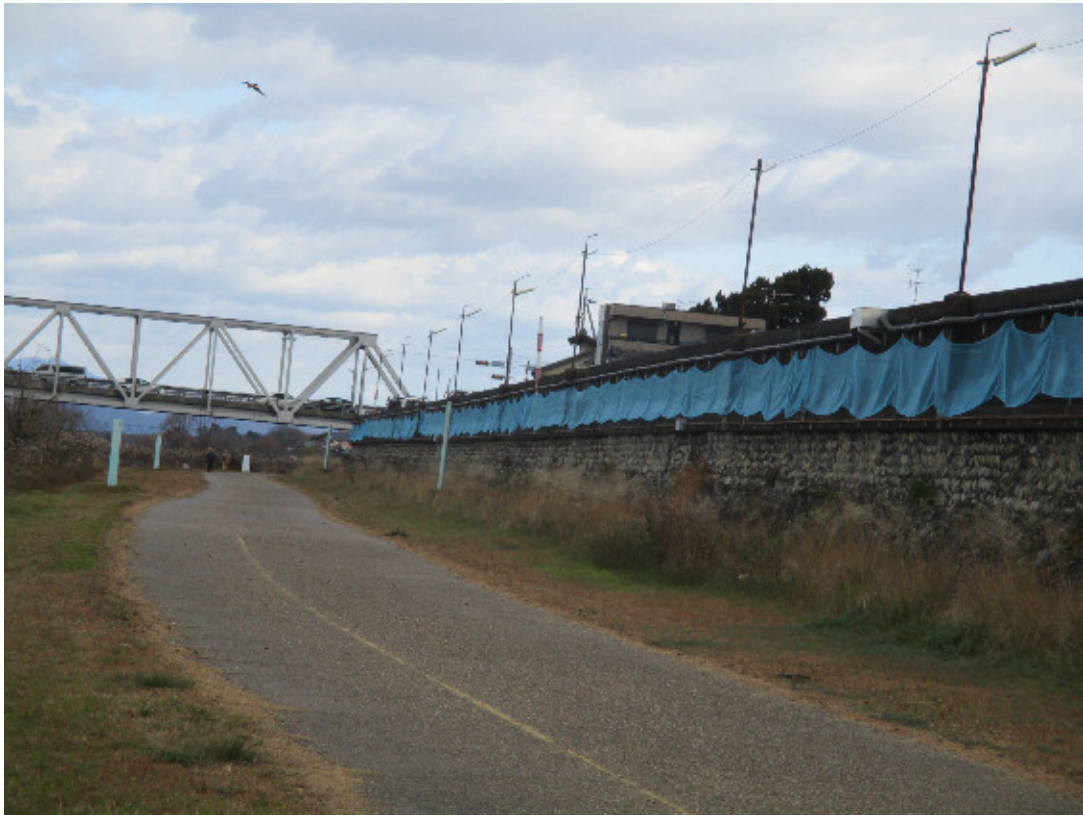
図 16 設置場所①（濃尾大橋下流側堤防）の防虫ネット設置状況
