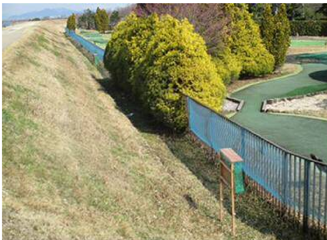
写真7 ③尾西グリーンプラザの防虫ネット設置状況
