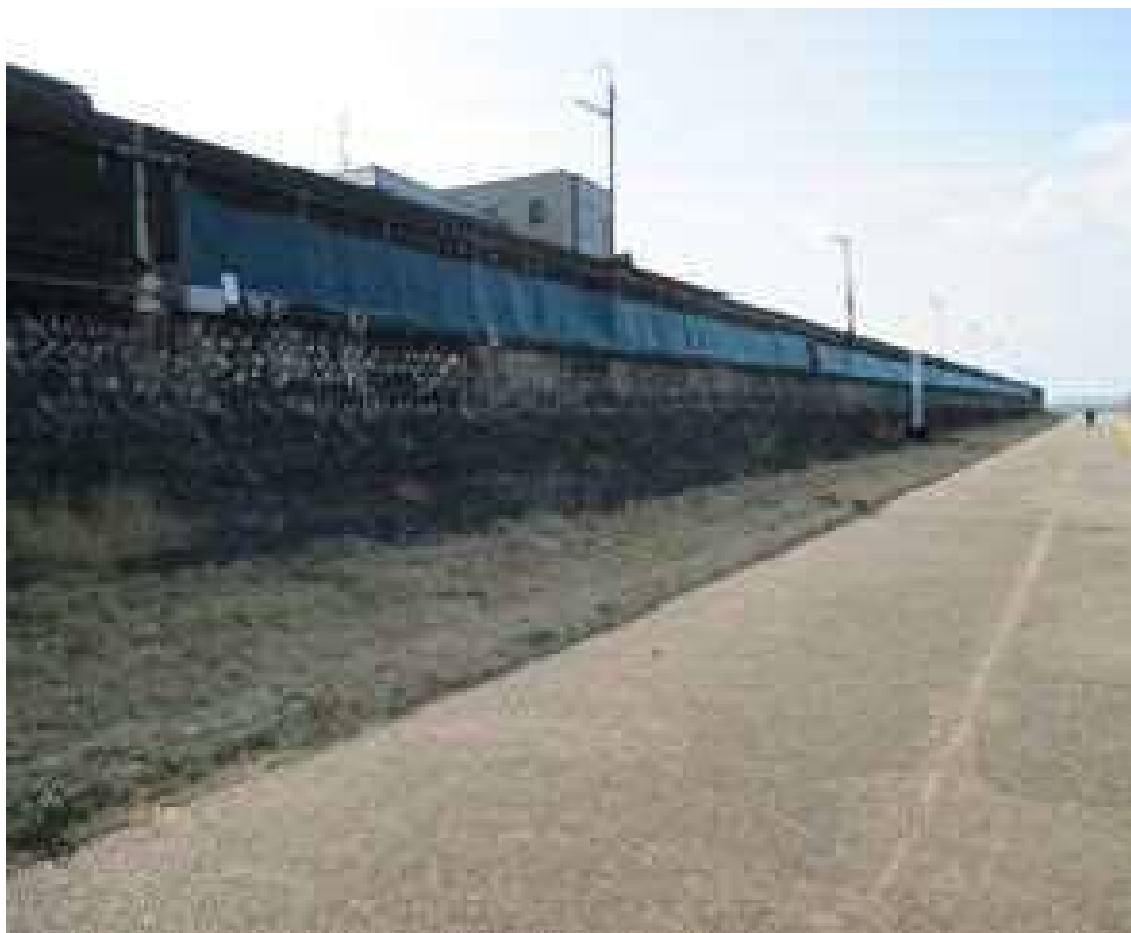
写真6 ①濃尾大橋下流側堤防の防虫ネット設置状況
