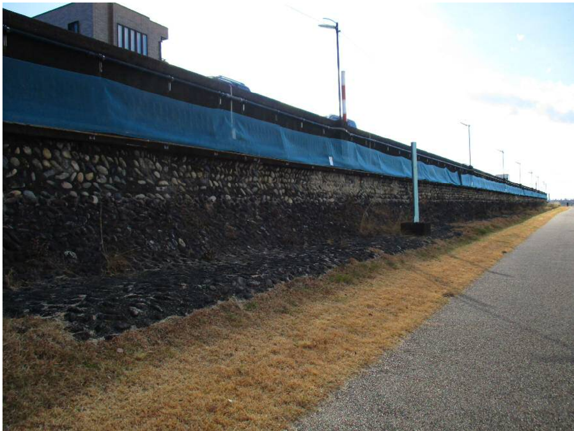
写真8 ①濃尾大橋下流側堤防の防虫ネット設置状況
