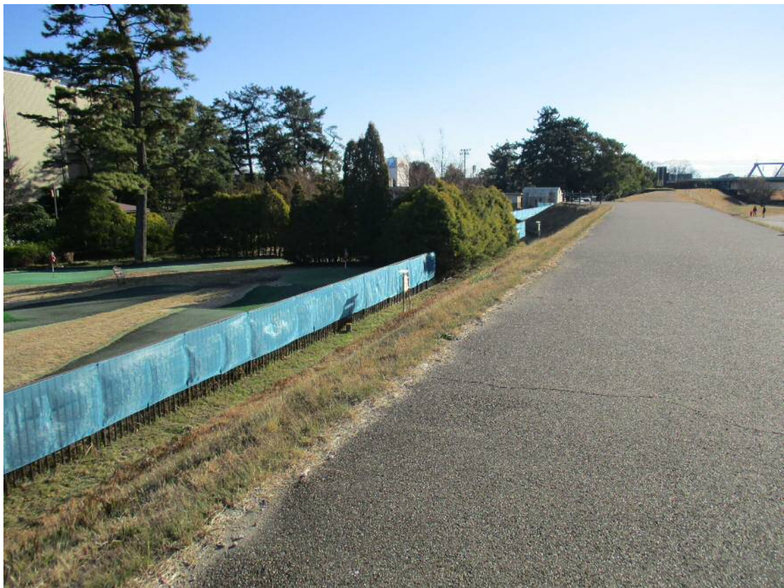
写真9 ③尾西グリーンプラザの防虫ネット設置状況
