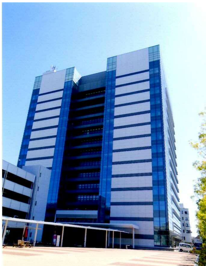
平成 26 年 一宮市役所新庁舎完成
