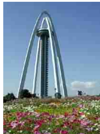
国営公園 138 タワーパーク
