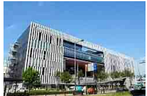
i-ビル(尾張一宮駅前ビル)
