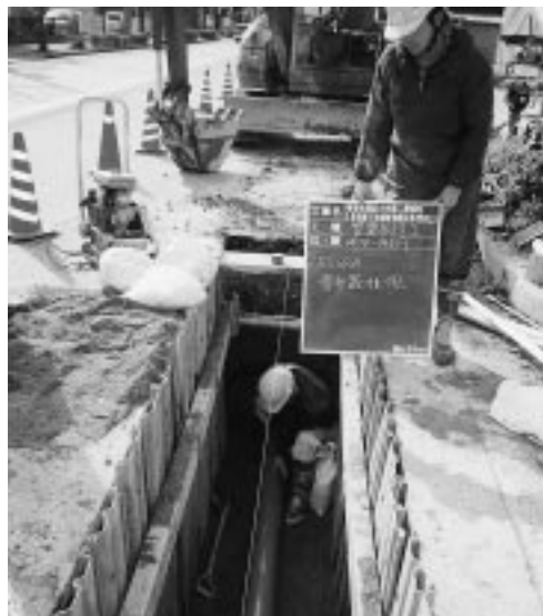
現在進められている下水道工事風景
