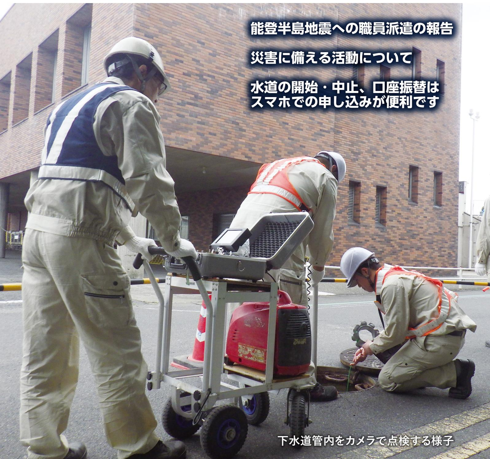
下水道管内をカメラで点検する様子
