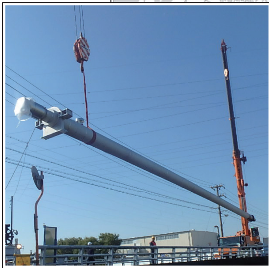
水管橋設置工事の様子 (2025年11月撮影)
