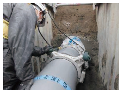
基幹管路の耐震化工事
