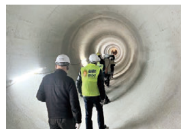
雨水管内部(工事見学会より)
