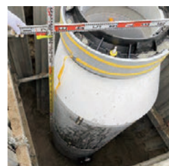
マンホール設置
