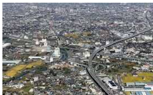
一宮インターチェンジ
