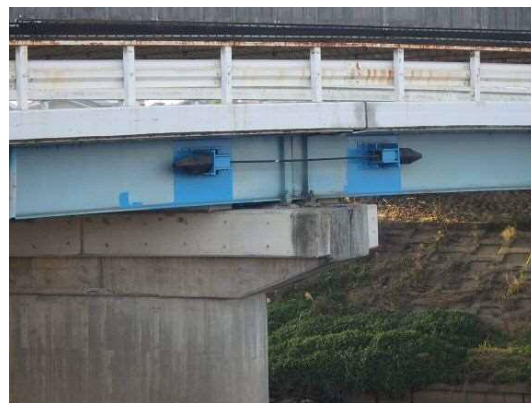
桁と桁をつなげる (萩原南橋)
