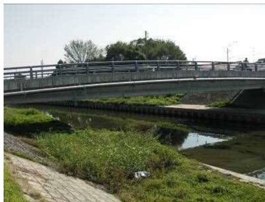
鉄筋コンクリートで造られた橋 (三崎橋)
