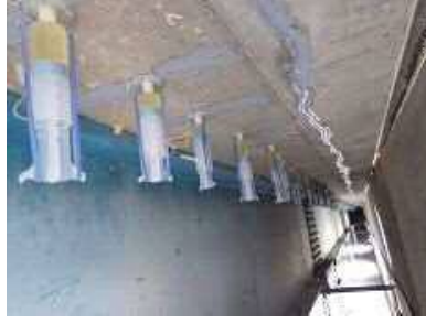
注入材・シール材充填
