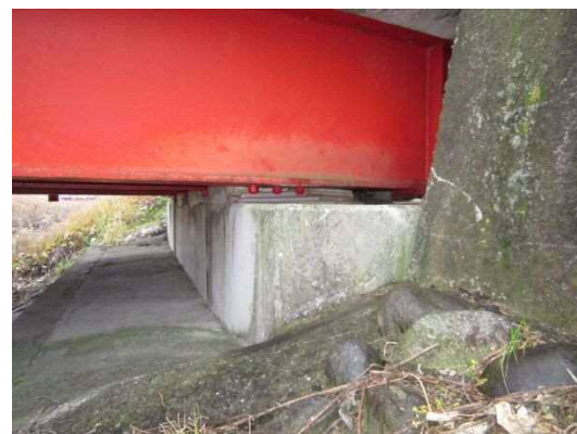
橋台を広げる (大和橋)
