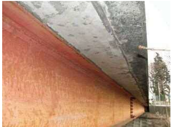
桁の防食機能の劣化
