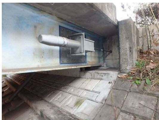
桁と橋台をつなげる (野黒橋)
