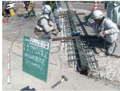
取替状況 簡易鋼製
