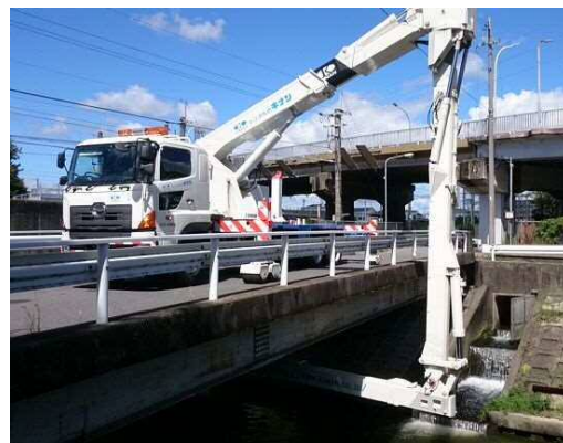
橋梁点検車による点検
