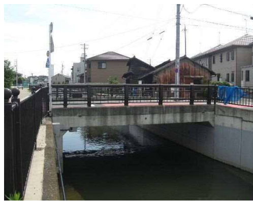
箱型の形をした鉄筋コンクリート製の構造物 (寺屋敷橋)
