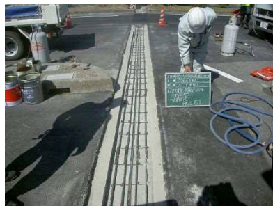
取替状況 埋設型
