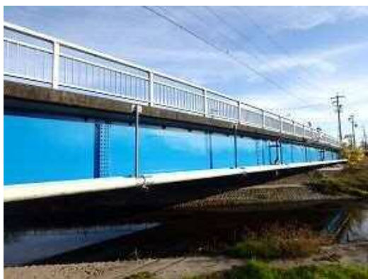
主な部材が鋼鉄で造られた橋 (小山新橋)
