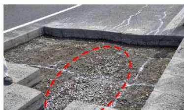
路盤の損傷の例 (路盤の細粒分がポンピングにより流失し、碎石が集まっている状況)
