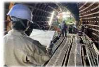
雨水管建設工事
