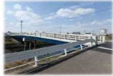
日吉橋橋梁保全事業
