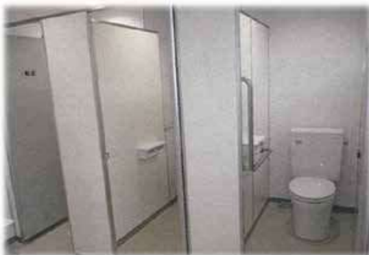
トイレ改修事業
