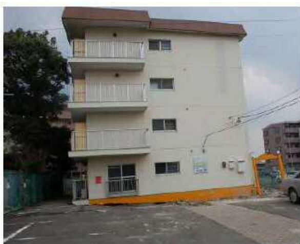
建物の基礎が崩壊、又は基礎がずれている。
