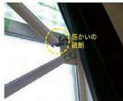
柱と柱の間の筋かい(斜めに入っている建物を補強しているもの)が切れている。
