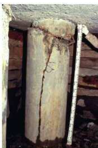
建物の基礎が崩壊、又は基礎がずれている。
