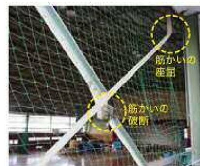
柱と柱の間の筋かい(斜めに入っている建物を補強しているもの)が切れている。
