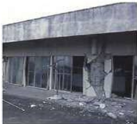
鉄筋が曲がり内部コンクリートも崩れ落ちている。
