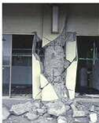
鉄筋が曲がり内部コンクリートも崩れ落ちている。
