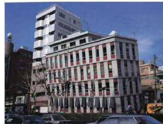
建物全体、又は一部が傾斜している。
