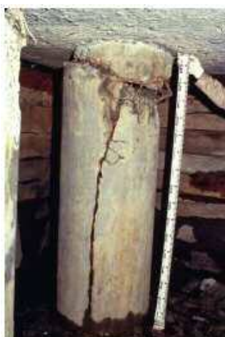
建物の基礎が崩壊、または基礎がずれている。
