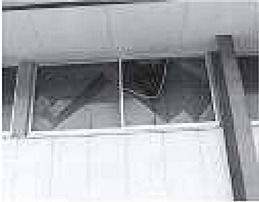
窓枠、窓ガラスに歪みやひび割れがある。
