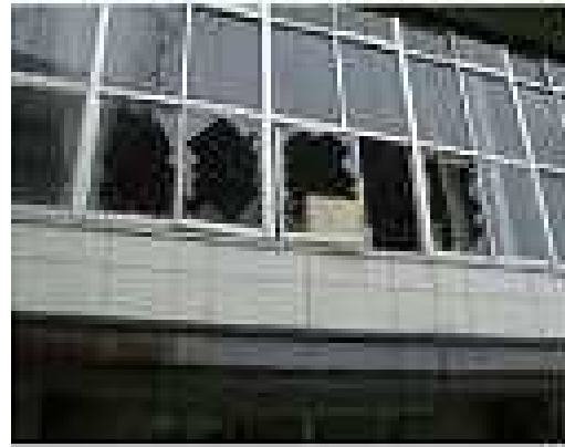
窓枠、窓ガラスに歪みやひび割れがある。
