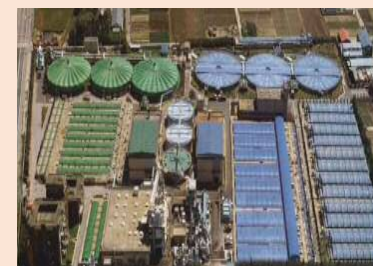
西部浄化センター
