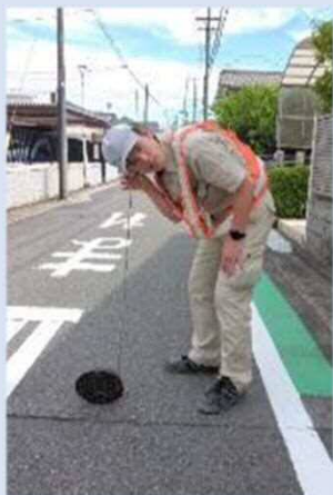
音聴棒にて仕切弁の漏水音の有無を確認
