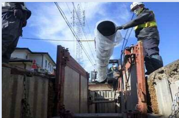
基幹管路の耐震化工事の様子
