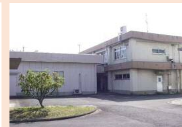
下水水質検査棟
