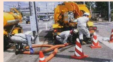
下水道管清掃状況
