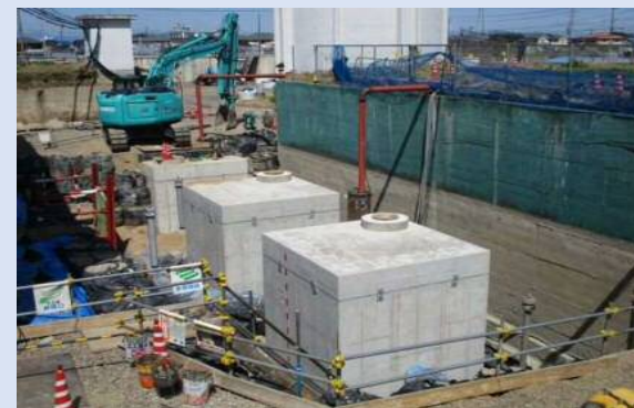
佐千原浄水場場内配管工事
