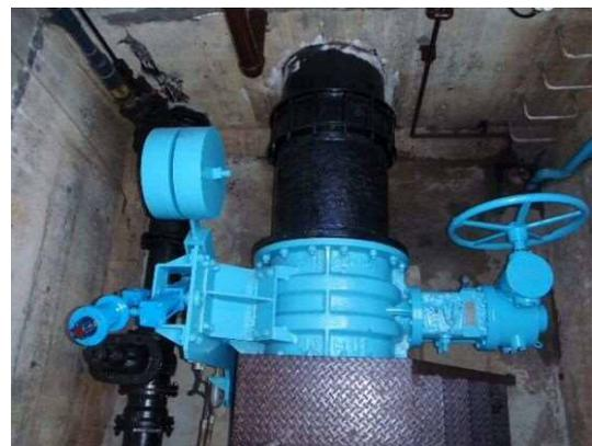
配水場の緊急遮断弁設置状況
