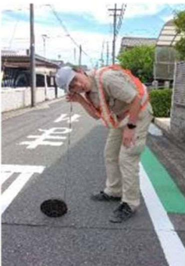
音聴棒にて仕切弁の漏水音を確認
