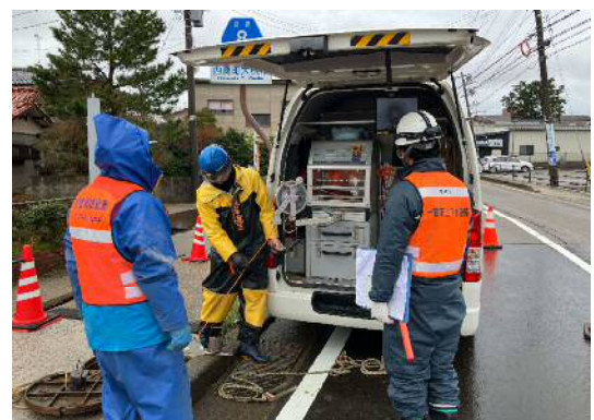
管路内の清掃作業
