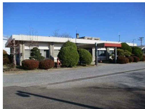
木曽川配水場
