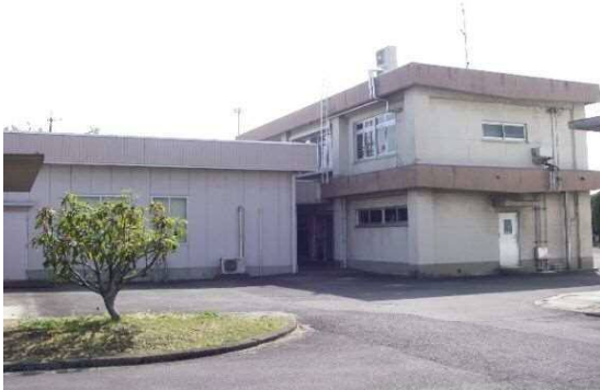
下水水質検査棟
