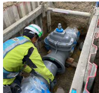
2024年度 基幹管路の耐震化工事の様子
