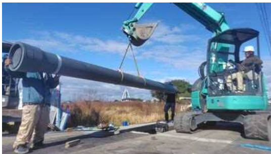
2024年度 基幹管路の耐震化工事の様子
