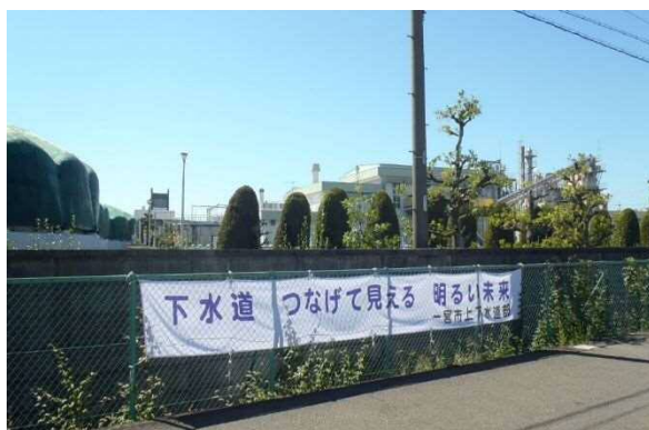
西部浄化センター
