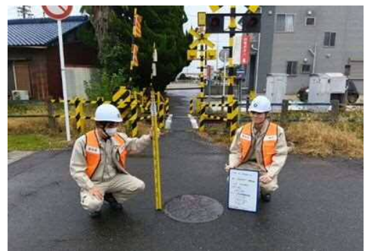
上下水道BCPに基づく 管路の緊急調査訓練の状況
