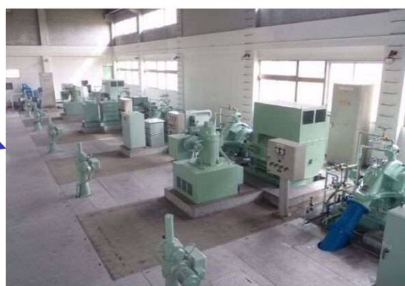
旧ポンプ棟ポンプ室
