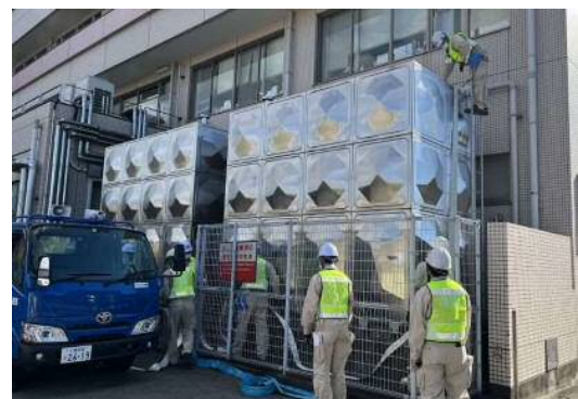
病院の受水槽への応急給水訓練の状況
