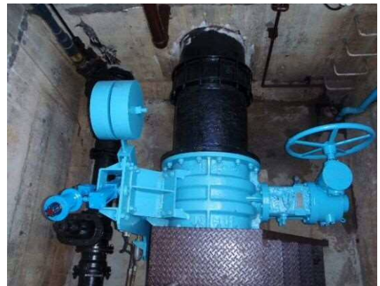
配水場の緊急遮断弁設置状況
