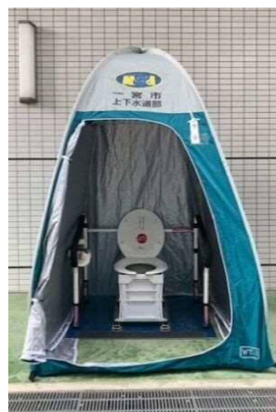
災害用マンホールトイレ設置例
