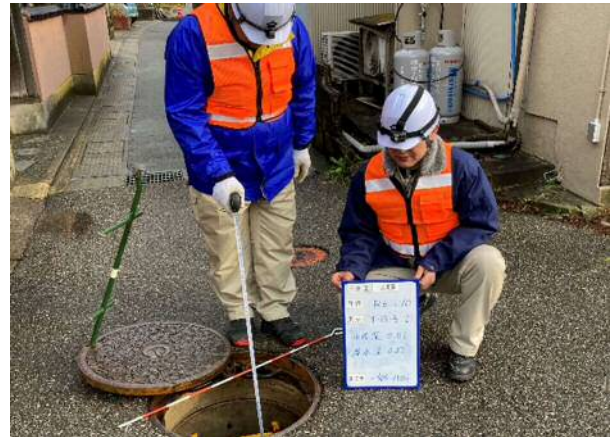
目視による被害状況調査
