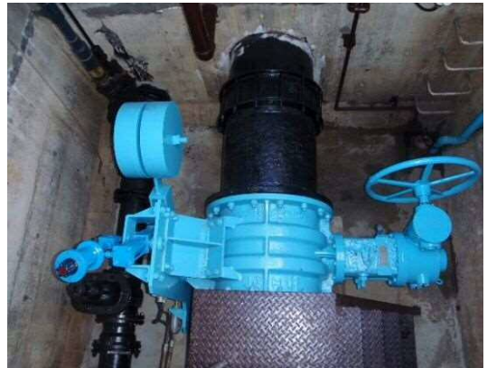
配水場の緊急遮断弁設置状況
