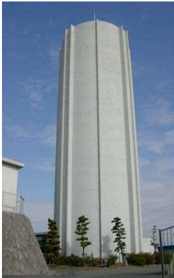
佐千原浄水場配水塔
