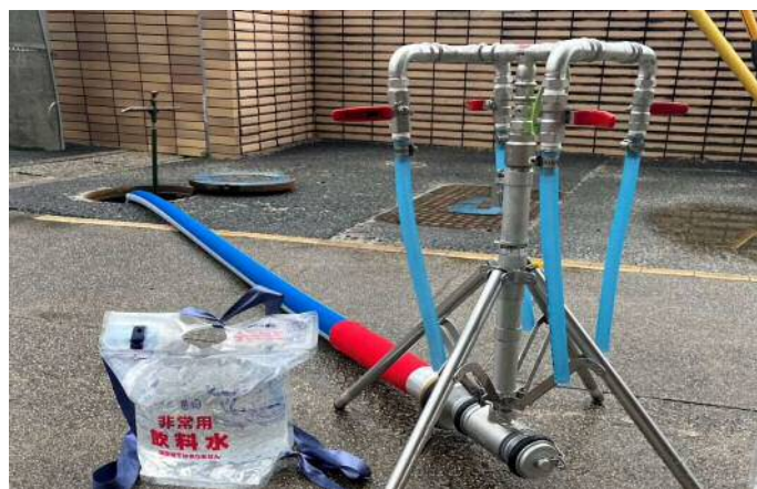
応急給水栓設置状況
