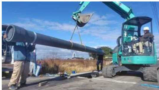
2024年度 基幹管路の耐震化工事の様子
