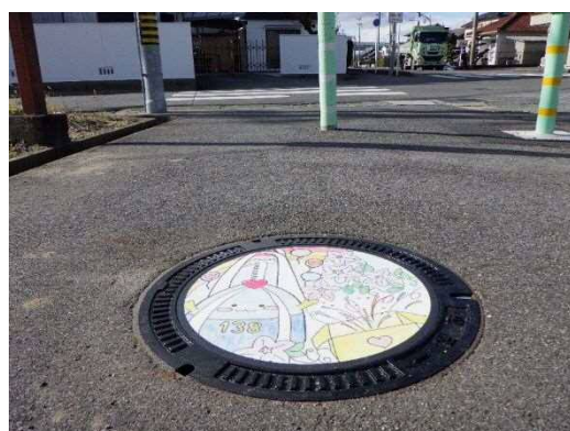
歩道に設置した様子
