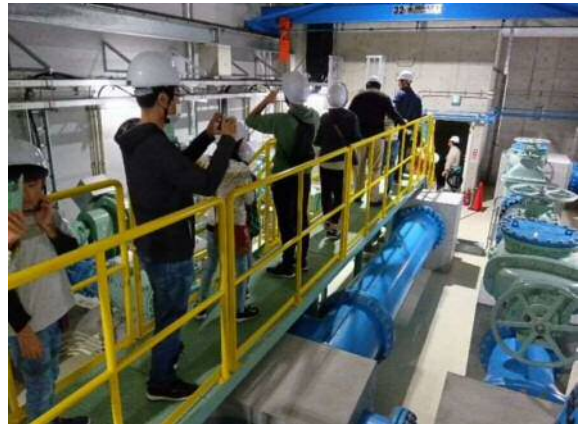
佐千原浄水場ポンプ棟ポンプ室
