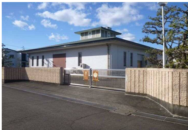
観音寺ポンプ場 （分流式）
