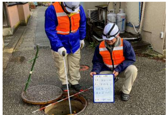
目視による被害状況調査
