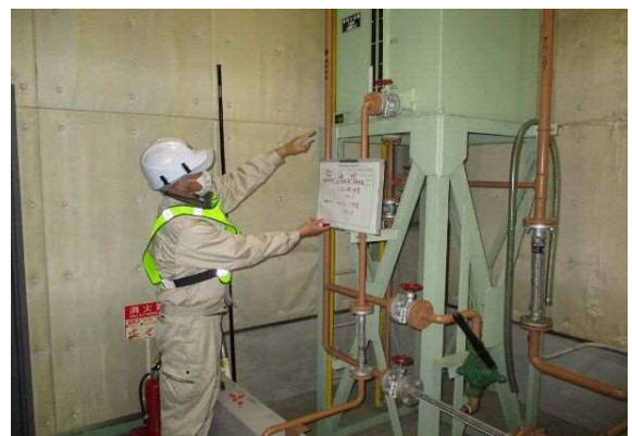
上下水道BCPに基づく 施設の緊急調査訓練の状況
