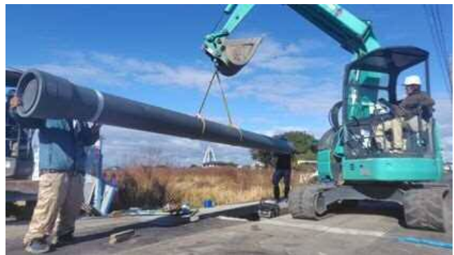
基幹管路の耐震化工事の様子
