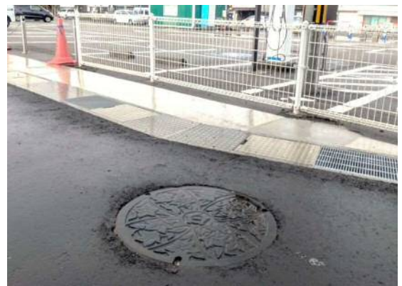
高岡市に設置された一宮市のマンホール蓋
