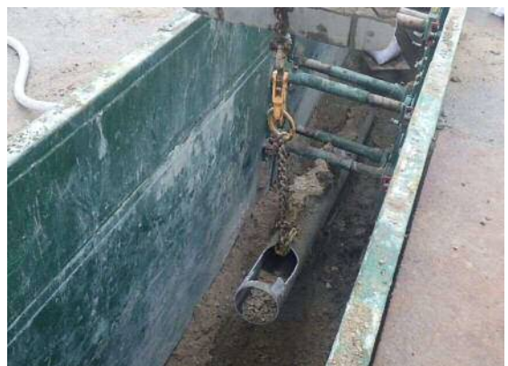
地震で破損した汚水管の撤去
