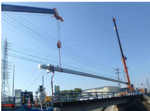
基幹管路の耐震化工事の様子
