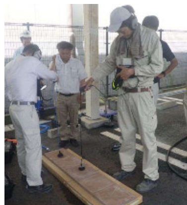
漏水調査機器の現場実習の様子
