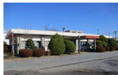
木曽川配水場
