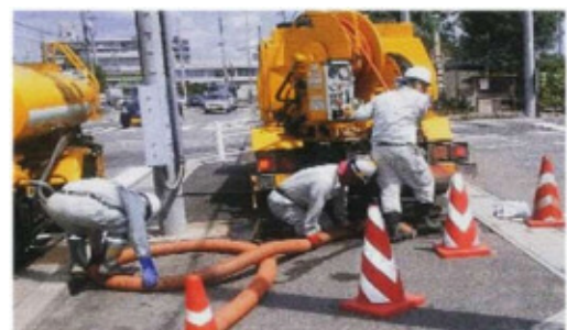
下水道管清掃状況
