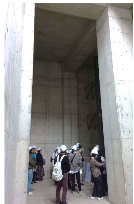
見学会の様子（北園通貯留槽の内部）
