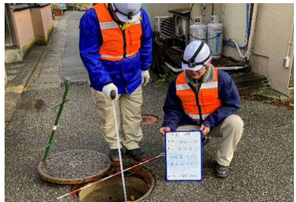
目視による被害状況調査
