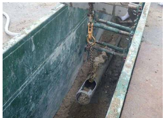
地震で破損した污水管の撤去
