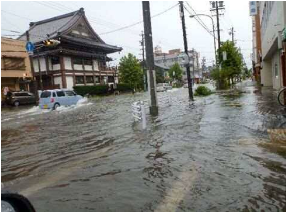
道路冠水の状況（2013年9月4日撮影）
