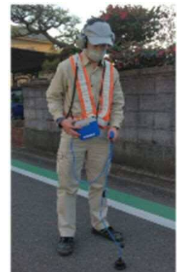
漏水探知器にて路面下の漏水音を確認
