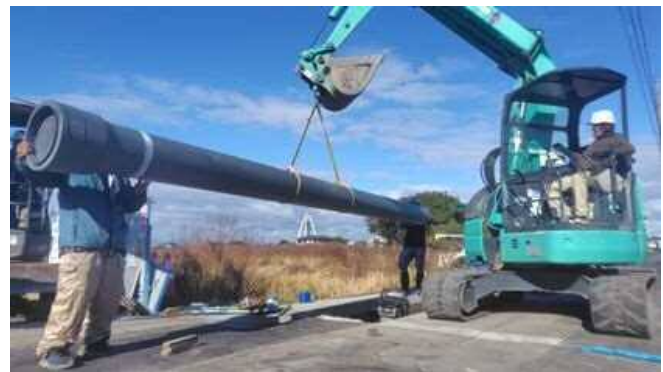
基幹管路の耐震化工事の様子
