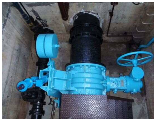
配水場の緊急遮断弁設置状況
