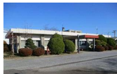
木曽川配水場
