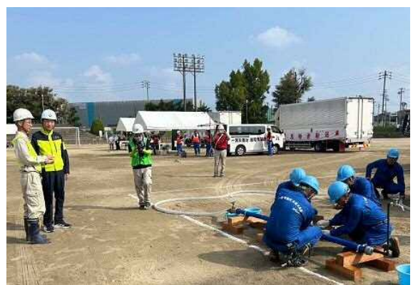
水道管の緊急修繕訓練の状況
