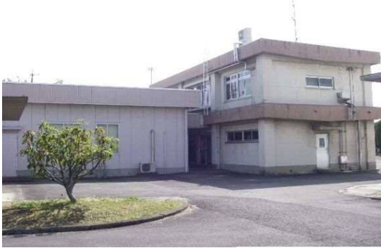
下水水質検査棟
