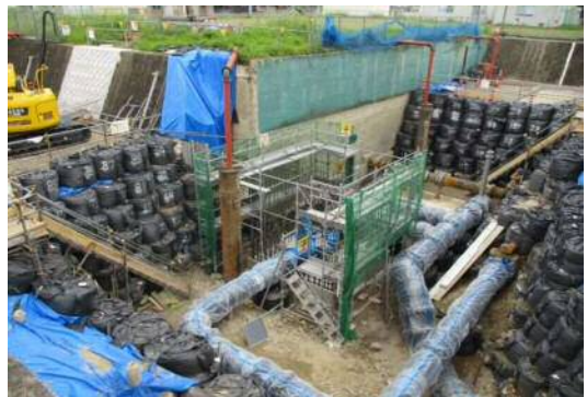
佐千原浄水場場内配管工事 2022年度施工中の様子
