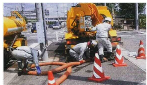
下水道管清掃状況
