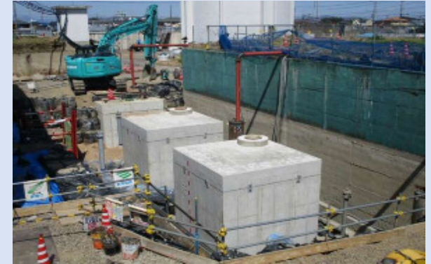
佐千原浄水場場内配管工事
