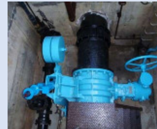
配水場の緊急遮断弁設置状況
