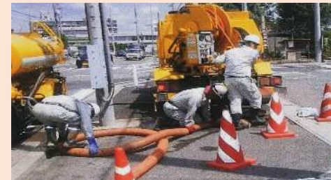
下水道管清掃状況
