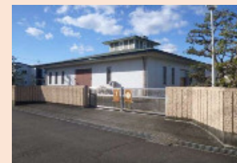
観音寺ポンプ場 分流式
