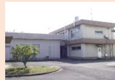
下水水質検査棟
