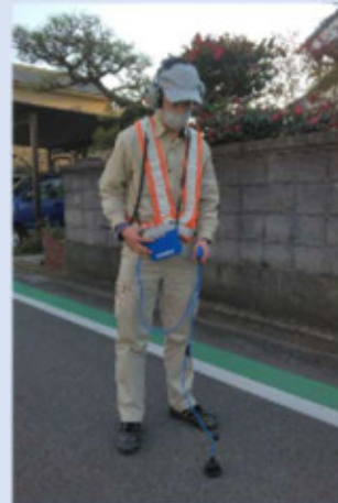
漏水探知器にて路面下の漏水音の有無を確認
