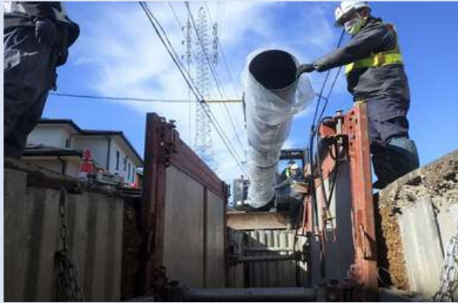
基幹管路の耐震化工事の様子
