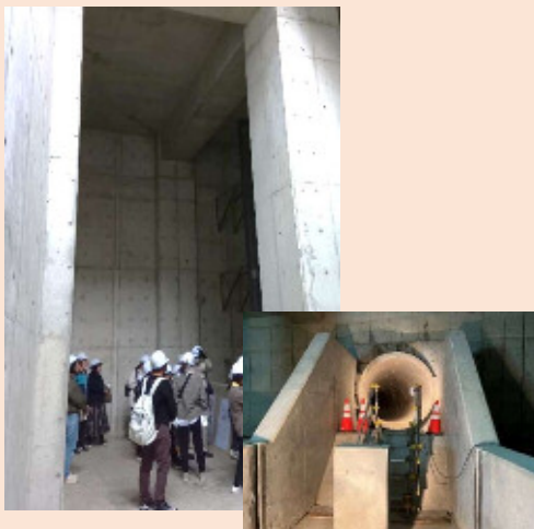
雨水貯留槽内部の様子
