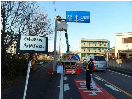
高所作業車による 近接目視点検実施状況
