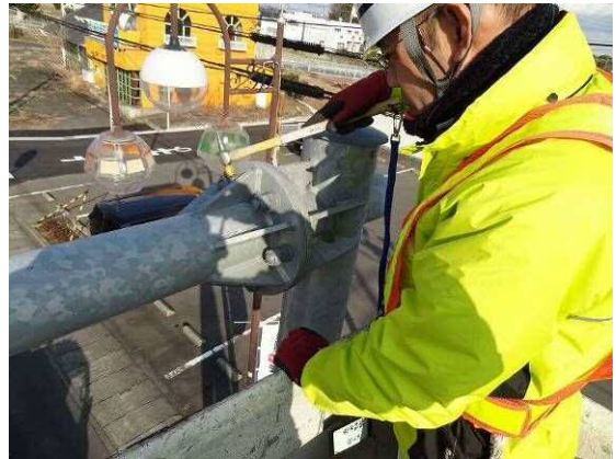
点検ハンマーによる ボルト緩み確認状況
