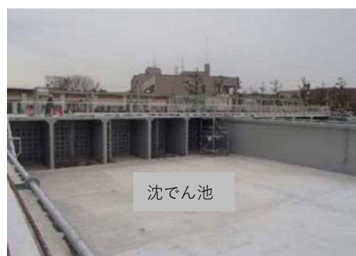
【東部浄化センター沈でん池】
