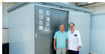
◀新たに設置した 防災倉庫
