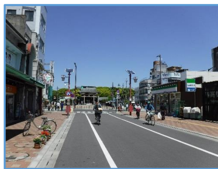
図-3 無電柱化整備済み箇所 (⑤ 市道0135号線)
