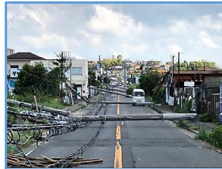
図-1 災害時の道路閉塞状況 (出典:国土交通省ウェブサイト)
