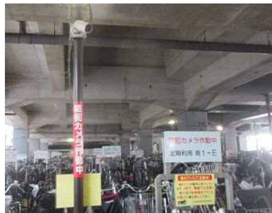
写真 5.3 駐輪場に設置された防犯灯、防犯カメラ
