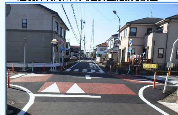
例：交差点ハンプ設置（令和元年10月完成）
