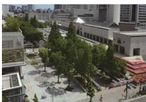
■横浜市 グランモール公園の透水性・保水性舗装
