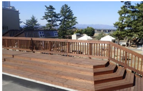
国産木材を使用したウッドデッキ (富田山公園)
