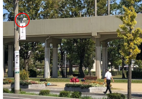
防犯カメラが設置された公園
