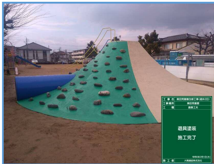
遊具の塗装完了
