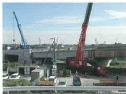
着々と進む工事
