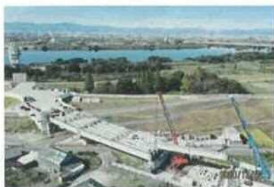
空から見た工事の状況
