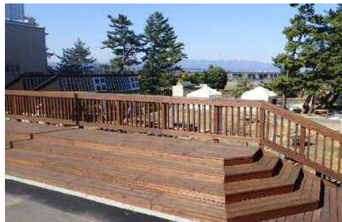
（1 ウッドデッキ、階段、 転落防止柵の設置）
