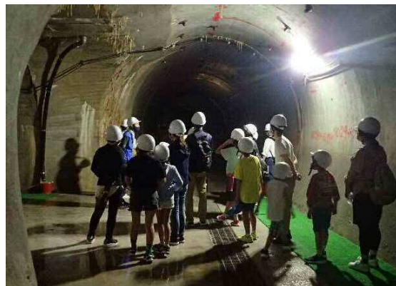
（味噌川ダム監査廊見学）
